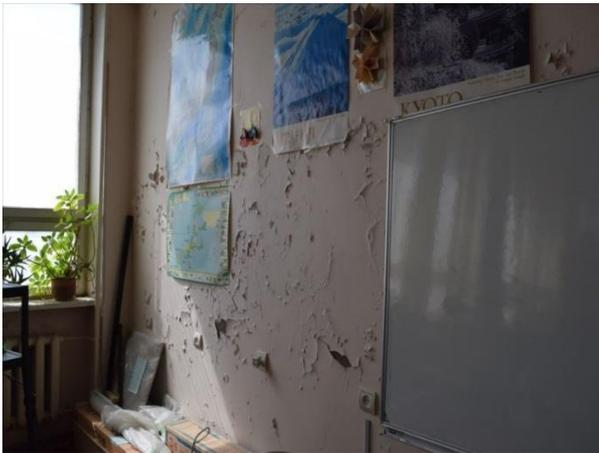
壁の塗装が剥げかけており、窓も完全に閉まらず、冷暖房もない。
