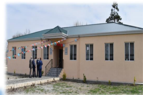
Project for Construction of Kindergarten in Pashabeyli Village of Aghdam Region Ağdam rayonunun Paşabəyli kəndində uşaq bağçasının inşası layihəsi
