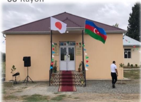
Project for Construction of the Annex Building for Yeni Khojavend Village School in Khojavend Region Xocavənd rayonunun Yeni Xocavənd qəsəbə məktəbində əlavə məktəb binasının inşası
