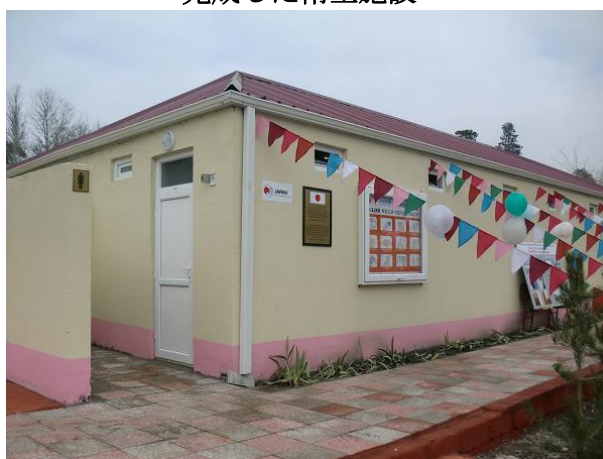
完成した衛生施設
