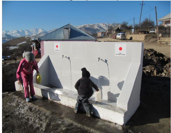
Layihə üzrə quraşdırılmış su kranı
