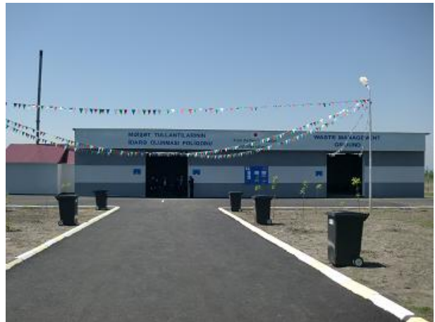
新規に建設されたごみ処理場
