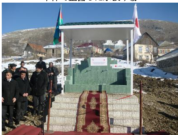
本件で整備した水汲み場
