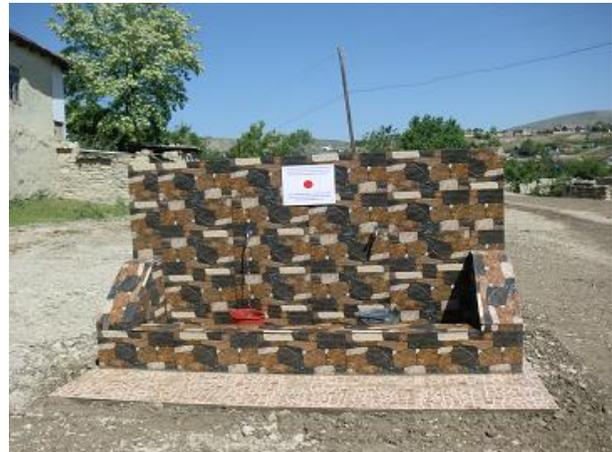
52 トンの鉄筋コンクリート製貯水槽
