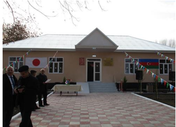
本件により建設された診療所
