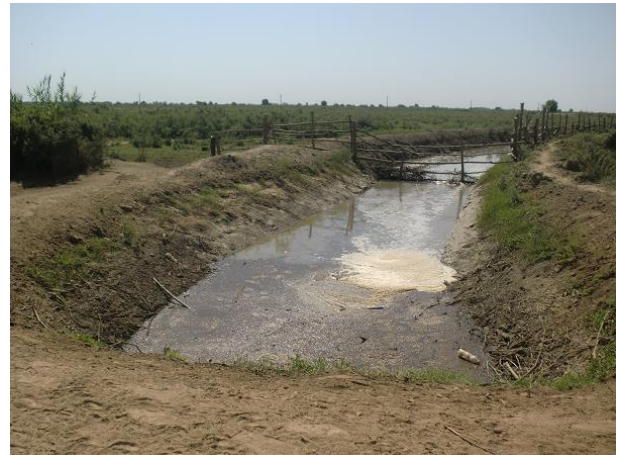
修復が必要な用水路
