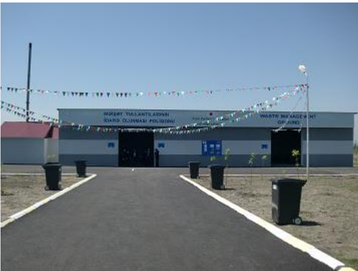
Yeni inşa olunmuş tullantıların idarəetmə sistemi
