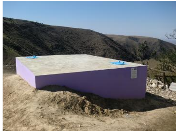
コンクリート製貯水槽
