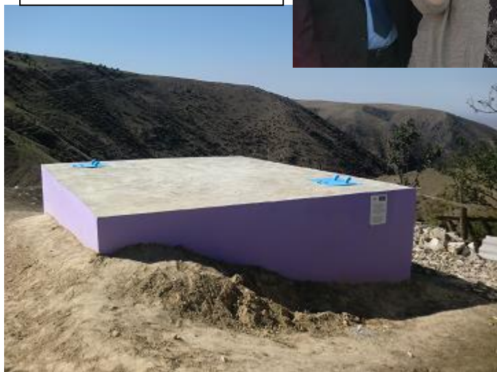
鉄筋コンクリート製貯水槽
