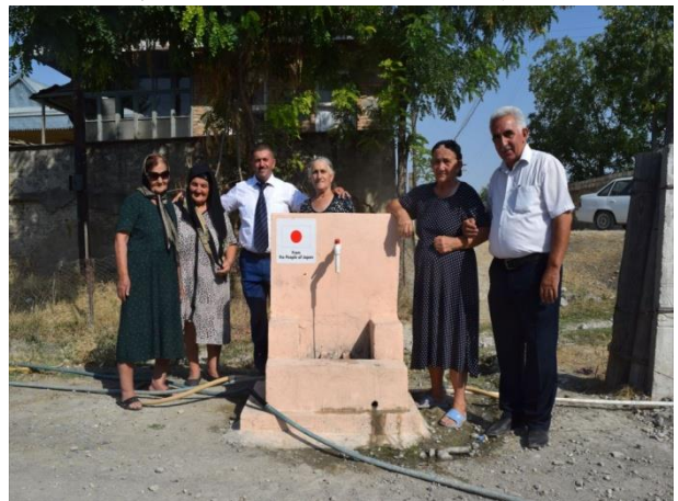
村内に建設された水汲み場
