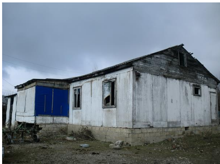
現在のガライベイリ村診療所建物 本件により新規に建物が建設され機材が整備される
