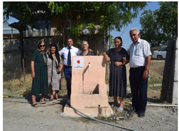
村内に建設された水汲み場
