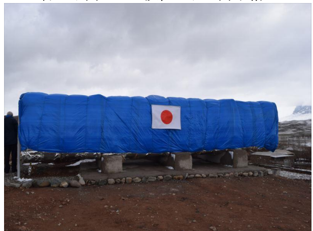
村の小高い丘に設置された貯水槽
